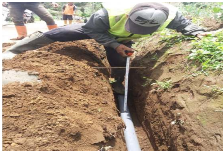
Gambar 3.11 Pembangunan Jaringan Air Minum Di Desa Plompong Kecamatan Sirampog
