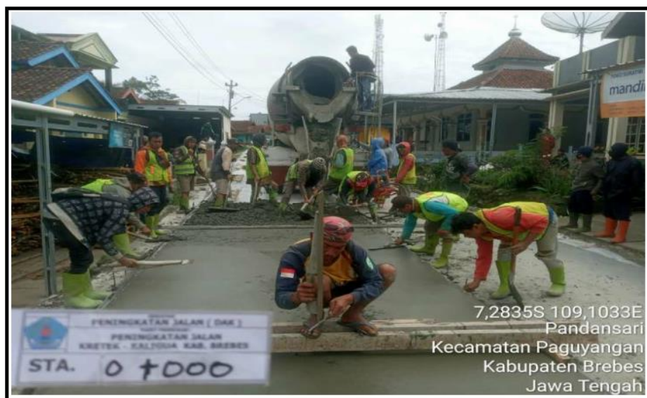
Gambar 3.11. Peningkatan Jalan Jl. Kretek - Kaligua
